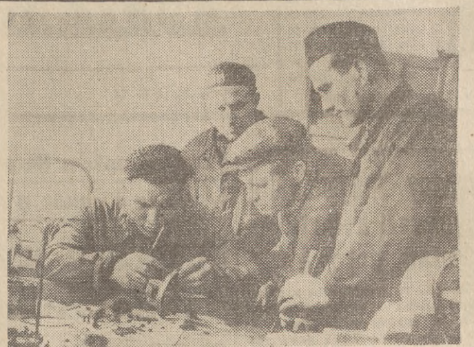
Fot. — Ferster Dział elektryczny warsztatów POM nr 8 w Nowym Stawie ma dobrze wyszkoloną fachową obsługę. W kwietniu br. założa tego działu powiększy się o parę osób. Na zdjęciu: Pracownicy działu elektrycznego regenerują osprzęt kolektora. Od lewej: Tadeusz Rudzik, Jan Dogedelski, Aleksander Sznajdziuk i Edward Rudzik.
