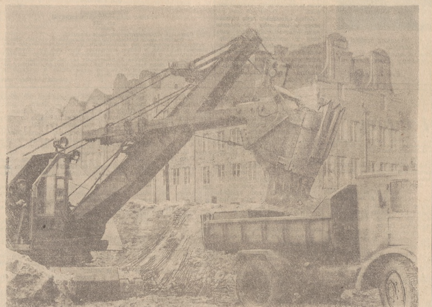
Tam, gdzie jeszcze niedawno pozostał chwast, gruzu i zgłiszczu, walczą wielkie koparki i wyrastają dziś nowe domy socjalistycznego Gdańska
