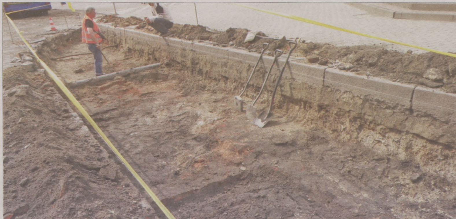
W tym wykopie archeolodzy odkopali fundamenty hotelu.
