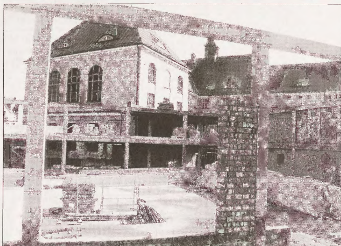
Budowa hali sportowej dla Liceum Ogólnokształcącego im. S. Dubois
