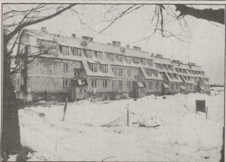
Czarne. Na osiedlu WDM trwa wykańczanie nowego domu mieszkalnego o interesującej architekturze. Budynek przy ul. Jerzego z Dąbrowy wzniesiony przez załogę Człuchowskiego Przedsiębiorstwa Budowlanego wkrótce zostanie zasiedlony. (ce)
