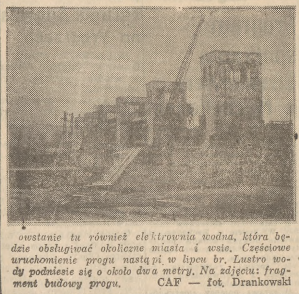
ustanie tu również elektrownia wodna, która będzie obsługiwać okoliczne miasta i wsie. Częściowe uruchomienie progów nastąpi w lipcu br. Lustro wody podniesie się o około dwa metry. Na zdjęciu: fragment budowy progów. CAF — fot. Drankowski
