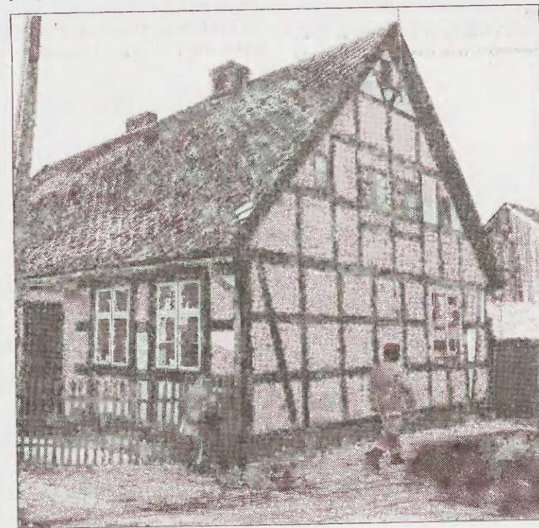
Stare szachulcowe budowle wsi Łącko w gm. Postomino
