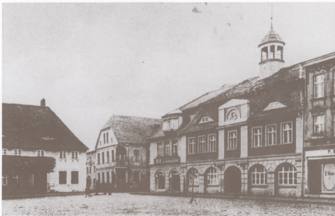
Ratusz po przebudowie.
