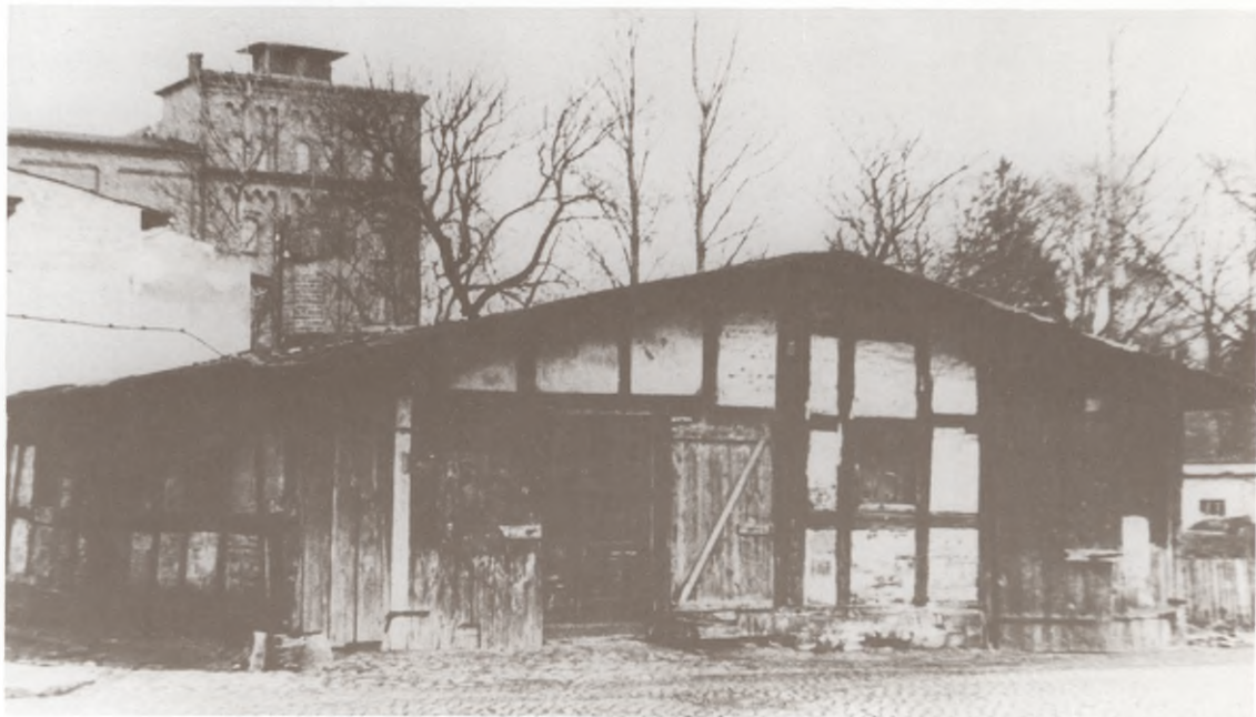
Stara stolarnia z pierwszej połowy XIX w. przy moście na obecnej ulicy Grottgera (zdjęcie z 1961 r.). Die alte Tischlerwerkstatt aus der ersten Hälfte des XIX Jahrhunderts. Die Werkstatt befand sich in der heutigen Grotterstrasse Photo aus dem Jahr 1961.
