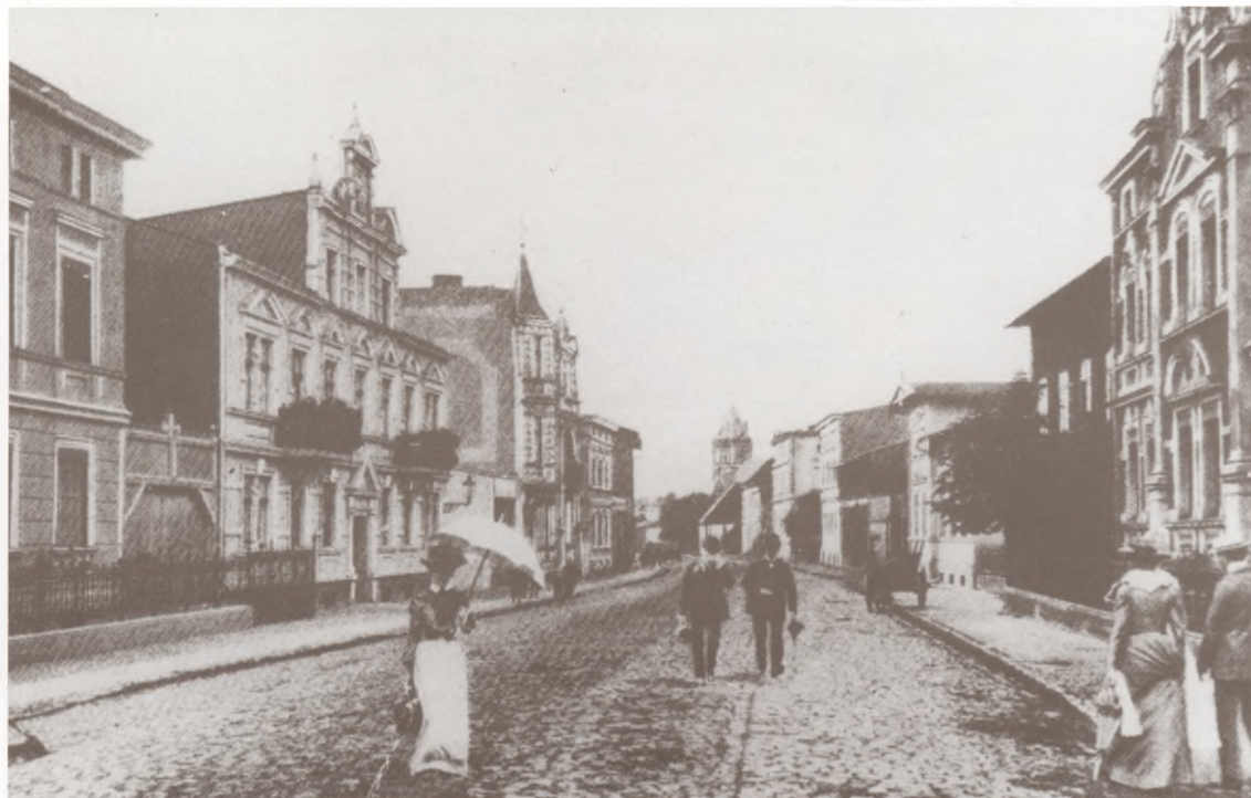
Obecna ulica Koszalińska. Zdjęcie z 1914 roku. Die heutige Koszalinskastrasse. Photo aus dem Jahr 1914.
