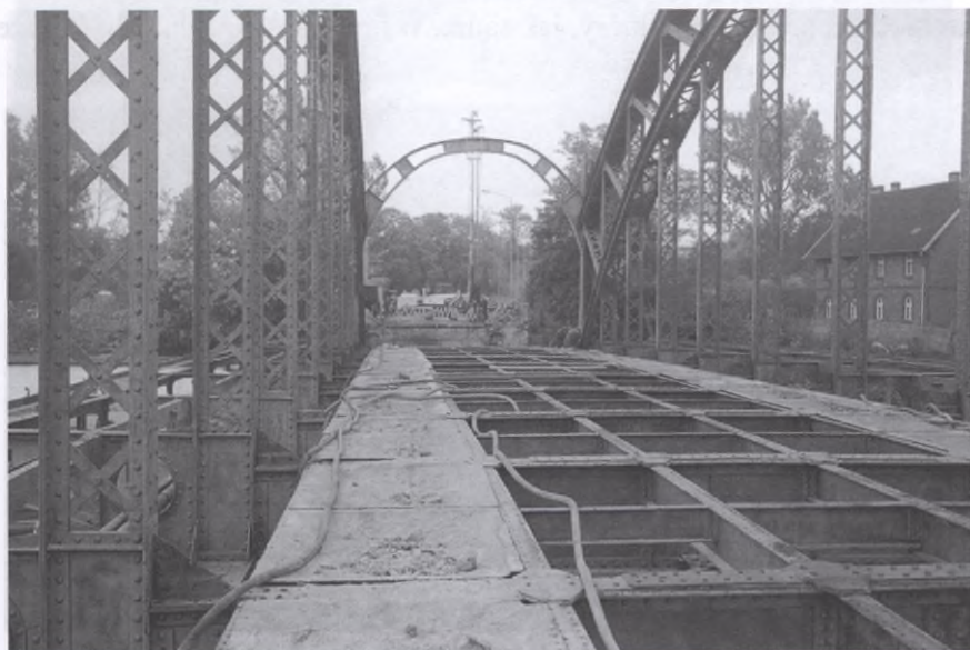
Remontowany wiadukt bytowski
