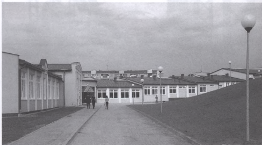
Nowa siedziba Szkoły Podstawowej nr 2 w Bytowie
