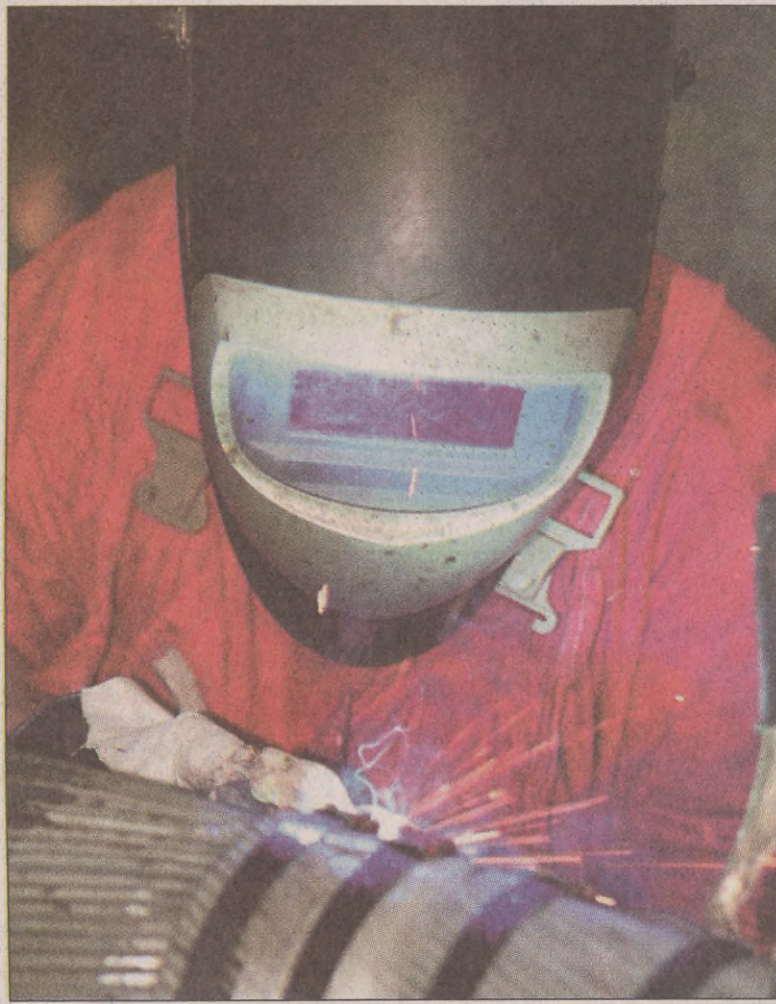
Ostatnie złącze wykonywano przez tydzień w tym żółtym namiocie. W tym czasie, ze względów technologicznych, komputer utrzymywał stałą temperaturę 21°C Zdjęcia Rafał Szamocki
