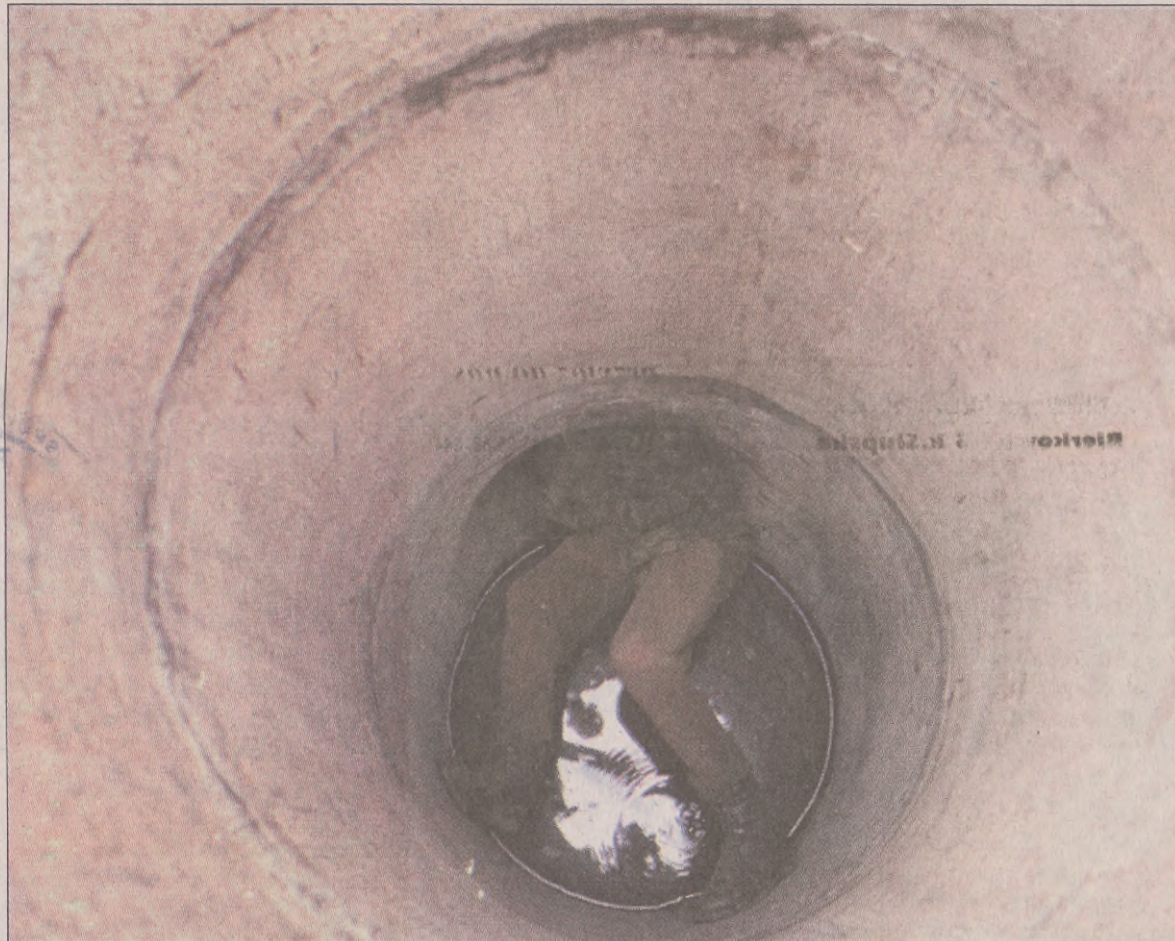
Do tunelu wchodzi się przez studnię.
