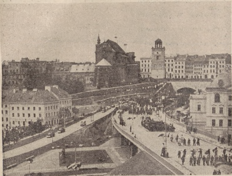
Trasa Wschód — Zachód, łącząca Warszawę lewobrzeżną z Pragą poprzez most Śląsko-Dąbrowski — to pierwsza wspólna, socjalistyczna budowa Polski Ludowej. Zapoczątkowała ona coraz bardziej nabierającą tempa budowę socjalistycznej Stolicy, coraz szybciej odbudowującej zniszczenia zadane wojną.
