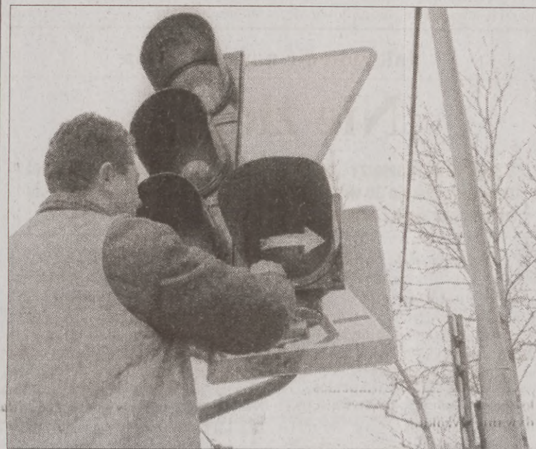
Montaż świecących strzałek wymaga regulacji całej sygnalizacji – wyjaśniają monterzy firmy „Trafic”
