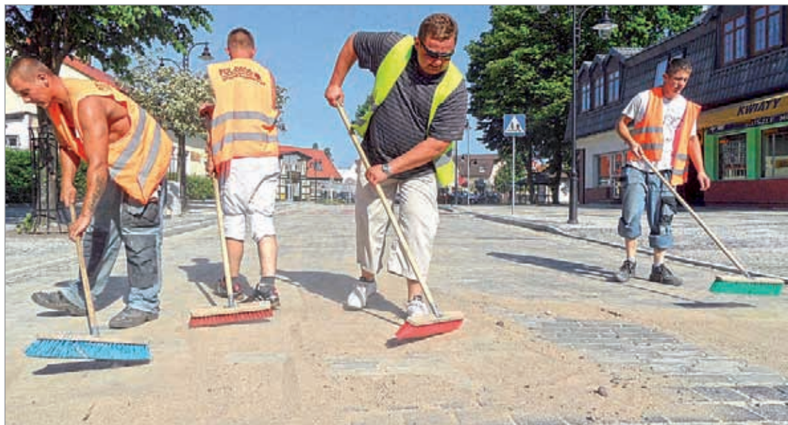
Ulica Marynarki Polskiej ma już nową nawierzchnię na całym odcinku. We wtorek drogowcy zmiatali jezdnię, przygotowując ją do odbioru.
