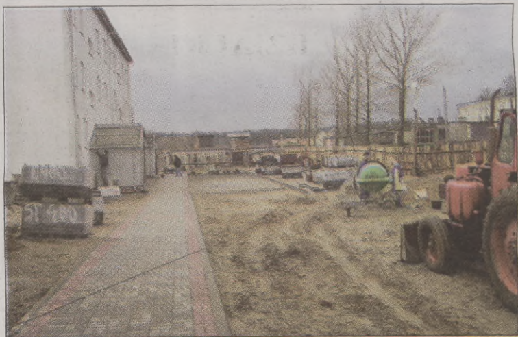
Przed blokami układane są już chodniki i drogi dojazdowe
