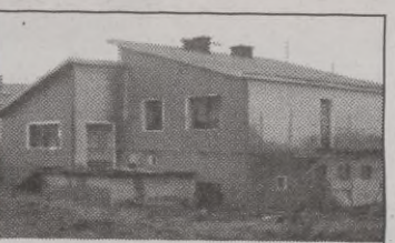
WYSOKIŃSKI – 342-36-44. Koszalin Raduszka dom stan surowy są tynki, instalacje 110 000 zł
