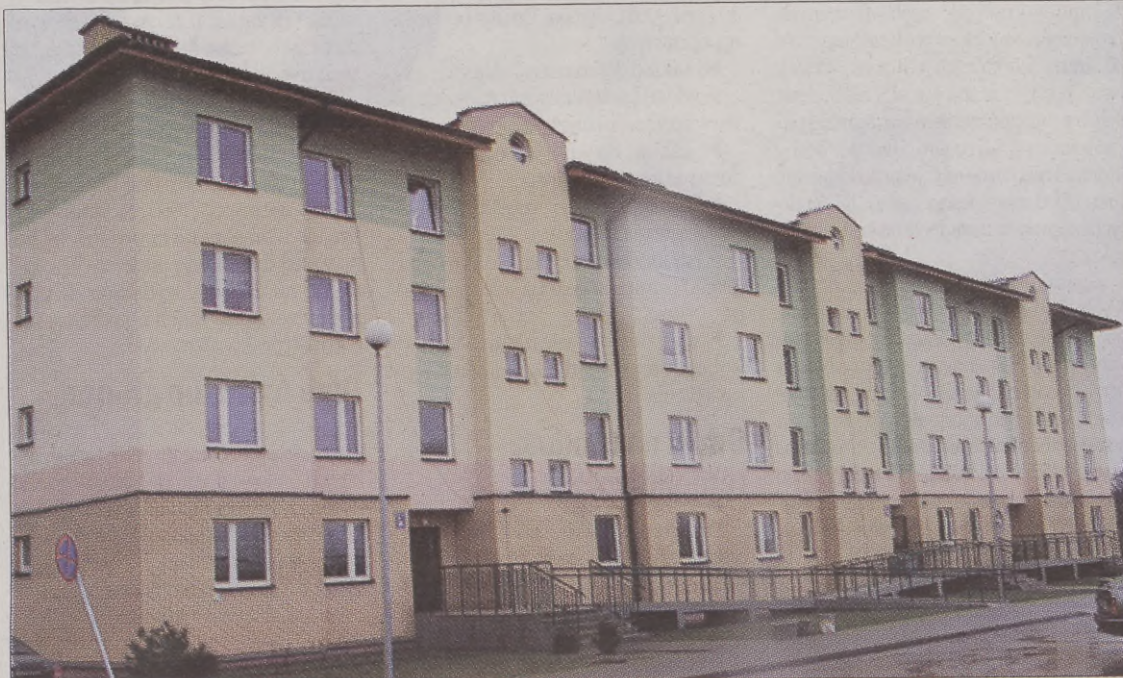
Blok TBS w Szczecinku
