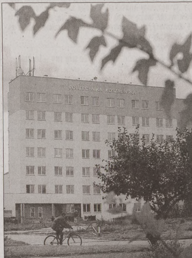
Nowy obiekt Politechniki Koszalińskiej przy ulicy Śniadeckich – tak zwany budynek C
