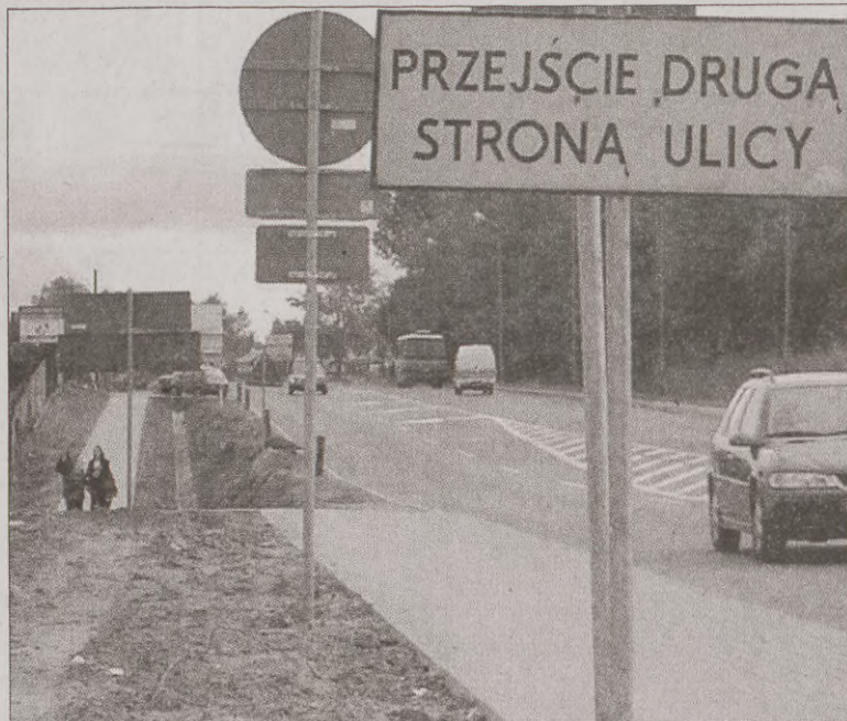
Tymczasem miło nam donieść, że drogowcy naprawiają błędy projektantów układu komunikacyjnego przy podślupskim hipermarkecie Real. Budowany jest chodnik, którym piesi będą mogli bezpiecznie się poruszać między Realem i rogatkami miasta. Wkrótce tablica będzie nieaktualna.
