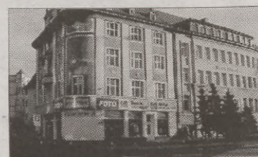
Lokal handlowo-biurowy (50m 2 ), parter, osobne wejście. Centrum Słupska do wynajęcia. Tel. 8402200, 608402200
