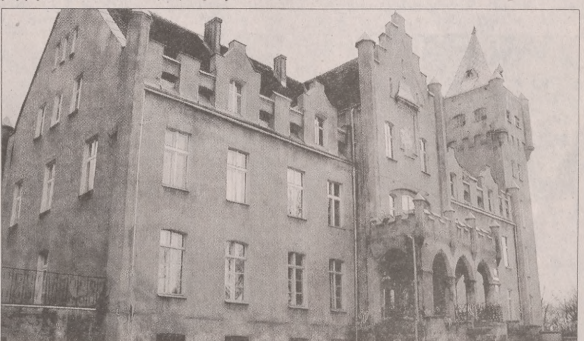
Pałac w Bukówku
