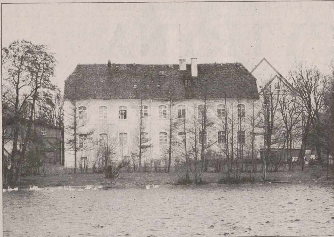
Szczecinecki Zamek Książąt Pomorskich już czwarty rok ma nowego właściciela i czeka na rozpoczęcie właściwego remontu
