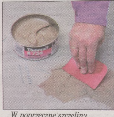
W poprzeczne szczeliny wkładamy metalowe kłamry i całość pokrywamy żywicą do napraw
