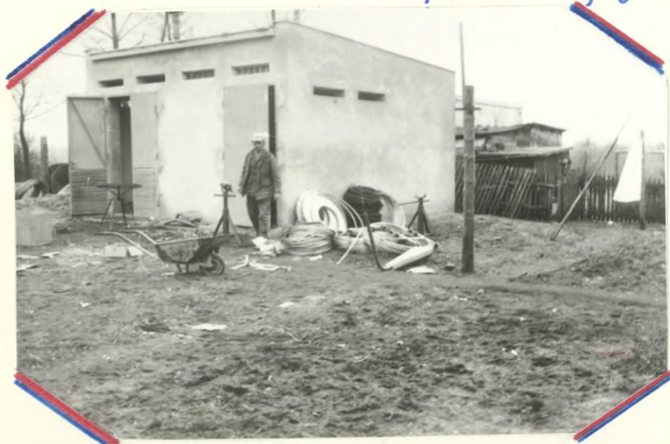
Nowy transformator w toku budowy
