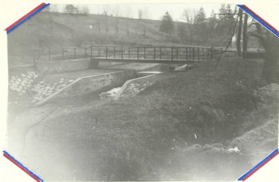
Lapora wodna na mece Gościcirze zabezpieczająca GFM w wodę dla P.Poż.
