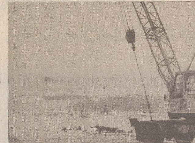
Mieszkańcy Koszalina długo czekali na tę chwilę: rozpoczęcie budowy nowego szpitala wojewódzkiego. Na placu zgromadzono już sporo ciężkiego sprzętu budowlanego, wykonano pierwsze wykopy pod fundamenty.
