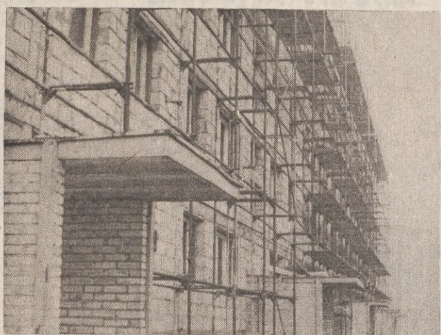
Wadą wielu budynków w naszych nowych osiedlach jest przemazanie ścian, zwłaszcza szczytowych. Na zdjęciu: przy ul. Sucharskiego w Koszalinie ocieplaniem budynku zajęła się ekipa Kolobrzskiego Kombinatu Budowlanego, jako że dom był budowany w tzw. systemie kolobrzskim. Zdaniem lokatorów — prace ciągną się zbyt długo.
