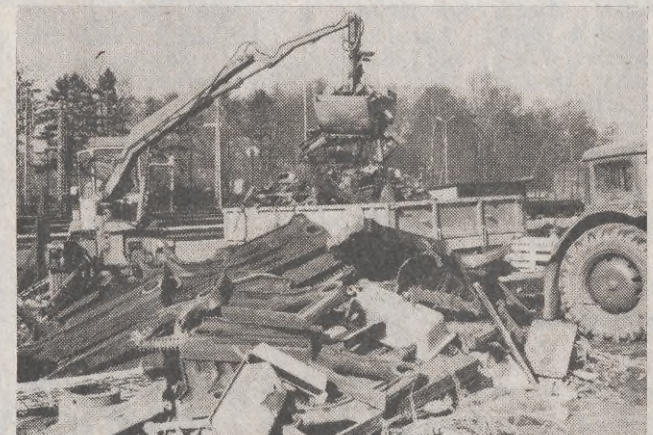
Pięta achillesowa naszej gospodarki: wykorzystanie surowców wtórnych. Tak ładowany jest złom na składowisku GS w Uście.
