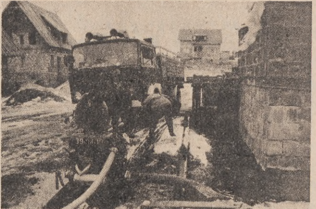
Nowe osiedle domków jednorodzinnych powstaje w Mławku przy ul. Kolejowej. Na nieszczęście nie odwołano wcześniej terenu; w następstwie podczas odwilży zostały zalane piwnice. Straż pożarna musiała pomagać właścicielom, ale nie mogła poradzić sobie z mrozem, który wkrótce przekształcił wodę w piwnicach w lód.
