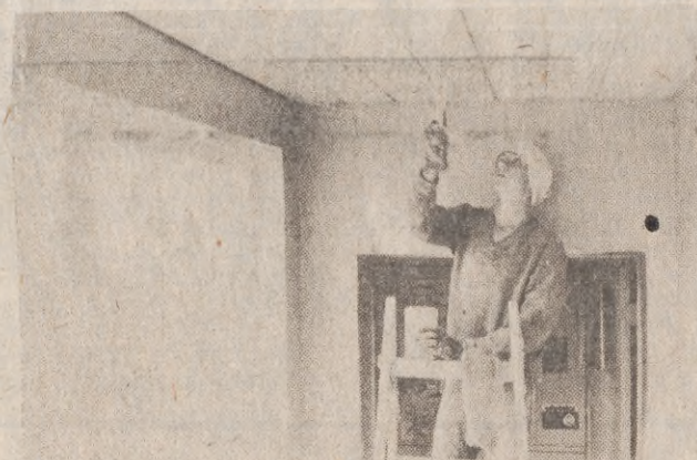
Do rozpoczęcia nowego roku szkolnego pozostał niecały miesiąc. Ekipę rzemieślników z Człuchowa, zastaliśmy przy malowaniu pomieszczeń szkoły w Starym Gronowie.
