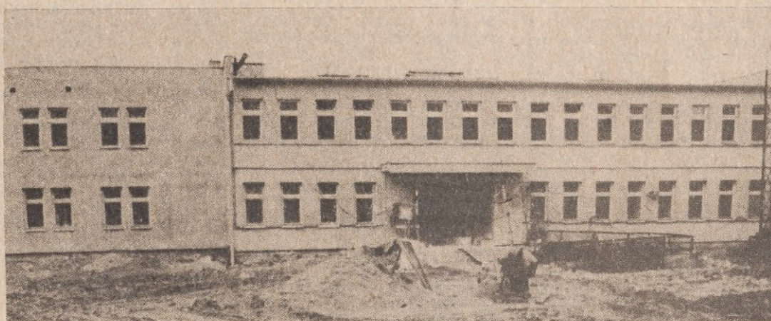
Gminny Ośrodek Zdrowia w Przechlewie — na zdjęciu jeszcze w budowie — dziś gotowy, by służyć mieszkańcom gminy. Fot. Jan Maziejuk
