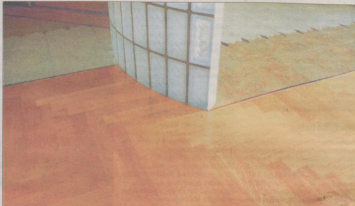
Niezależnie od tego, co położymy na podłożu – wykładzinę dywanową, parkiet czy płytki ceramiczne – posadzka pod spodem musi być równa, gładka i stabilna
