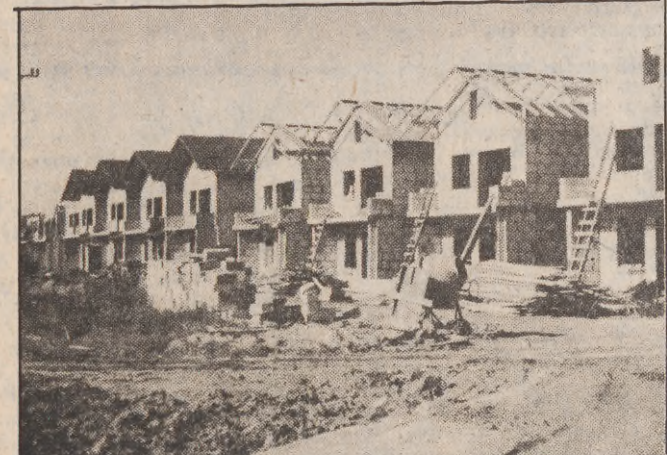
Budownictwo jednorodzinne zdobywa sobie w Koszalinie coraz więcej zwolenników. Na osiedlu Przylesie widać już wyraźnie efekty działalności kilku matych spółdzielni budownictwa jednorodzinnego.
