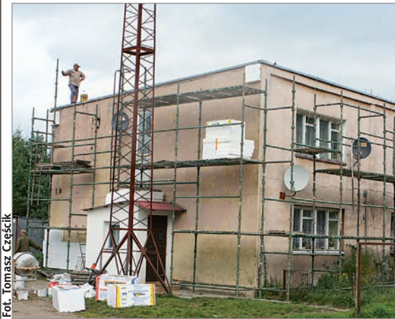
W Kępicach przy ul. Kruszką budynki są ocieplane.
