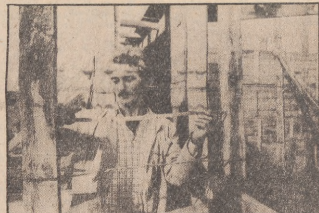
Przedsiębiorstwo Budownictwa Rolniczego w Lęborku podjęło budowę nowej szkoły w Nowej Wsi Lęborskiej. Budowlani wykonują ławy fundamentowe, zbudowano szalunki. Prace utrudniają niesprzyjające warunki geologiczne.
