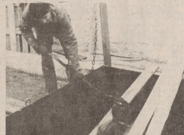
Zakład Przemysłu Drzewnego w Białogardzie jest producentem, znanych nie tylko na Pomorzu Środkowym, domków jednorodzinnych z elementów drewnopochodnych. Aby zapewnić im trwałość, impregnuje się je odpowiednimi środkami chemicznymi. Domek musi bowiem wytrzymać minimum 70 lat.
