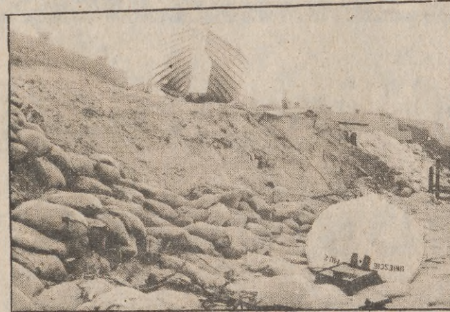
W grudniu, a następnie w styczniu sztormy wyrządziły sporo szkód na brzegu morskim. Uszkodzona była m.in. przystań rybacka w Unieściu koło Mielna. Do ratowania skarpy użyto ponad 2 tys. worków z piaskiem.
