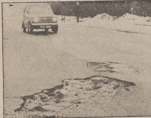
Tam, gdzie nie ma już śniegu i lodu, czyhają często na kierowców pułapki — dziury w asfalcie. Drogowcy w Koszalinie (zdjęcie wykonano na ul. Bieruta) będą mieli wiosną znów wiele pracy.
