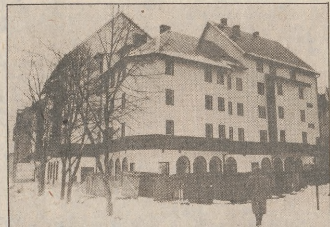
Jednym z przykładów niesablonowego rozwiązywania problemów mieszkaniowych w woj. słupskim jest budownictwo patronackie ZWAR w Lęborku. W tym domu o ciekawej sylwetce, w zabudowie plombowej, w 3- i 2-pokojowych lokalach otrzymają mieszkania 32 rodziny.
