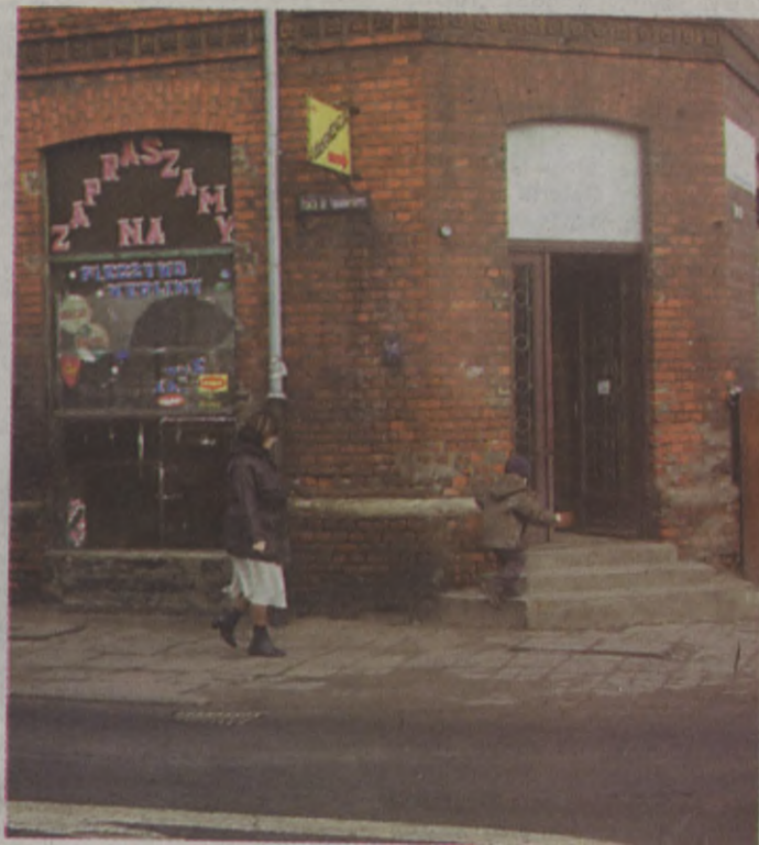
Właściciele sklepu nawet nie wstawiają nowych szyb w miejsce wybitych, bo wiedzą, że wandale wrócą.
