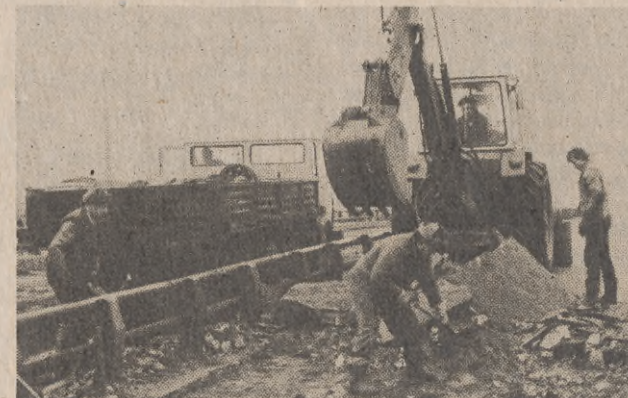
Wiadukt nad torami na ul. Wolność to jedno z najważniejszych miejsc w układzie komunikacyjnym Słupska. Od kilku miesięcy jedna połowa jezdni została wyłączona z ruchu. Drogowcy zrywają starą nawierzchnię i będą układać nową.
