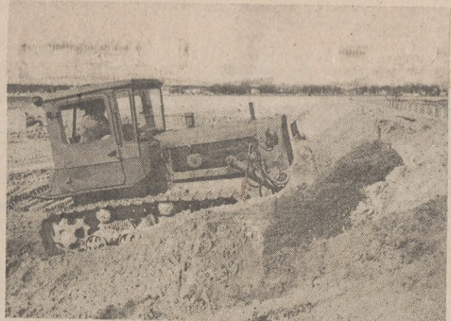
Wiele naszych wczasowisk rozwijało się w minionych latach bez elementarnego zabezpieczenia środowiska. Ostatnie lata przyniosły pewien postęp. W Rowach podjęto budowę oczyszczalni ścieków. Wykonawcą jest Spółka Wodna w Łebie, która wykorzystuje na tej budowie wcześniejsze doświadczenia z własnego miasta.
