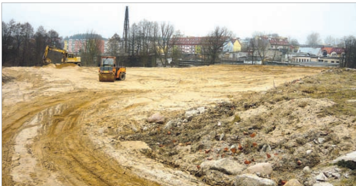
Od kilkunastu tygodni trwa przygotowywanie gruntu pod budowę marketu.
