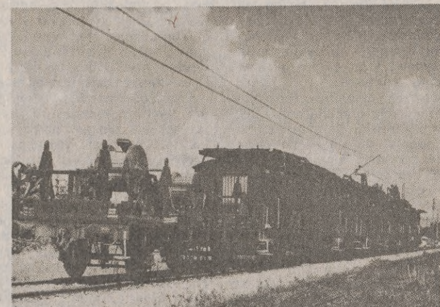
Za kilka dni ze Słupska do Łęborka i dalej będzie można już jeździć pociągami elektrycznymi. W okolicy Łęborka byliśmy świadkami ostatnich prób założonej niedawno nowej trasy.
