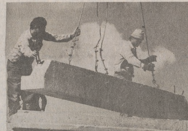
W Łęborku rośnie nowe osiedle „Sportowe”. Na budowie domu zastaliśmy brygadę Romana Kropidłowskiego.
