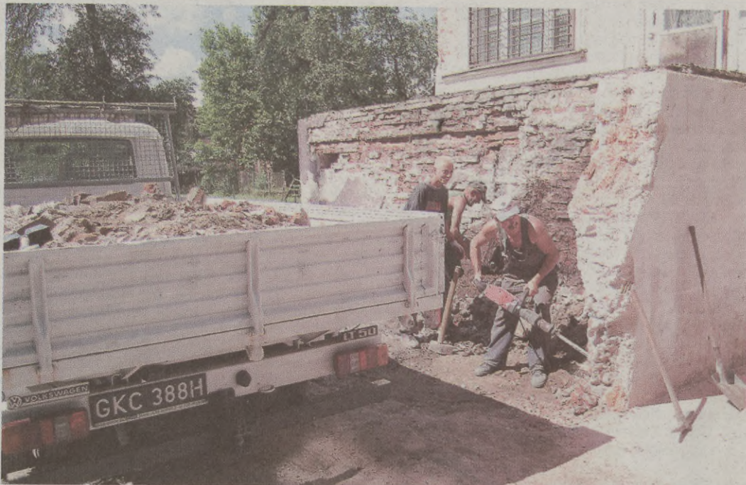
Remont budynku MOPR finansuje Urząd Miasta, kosztować będzie 300 tys. złotych.
