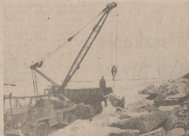
Na wschodniej części plaży w Uście ciąg dalszy prac umacniających brzeg. Wykonuje je Hydrobudowa z Gdańska. Te wielkie granitowe glazy będą niwelować nieco skutki uderzenia sztormowych fal.
