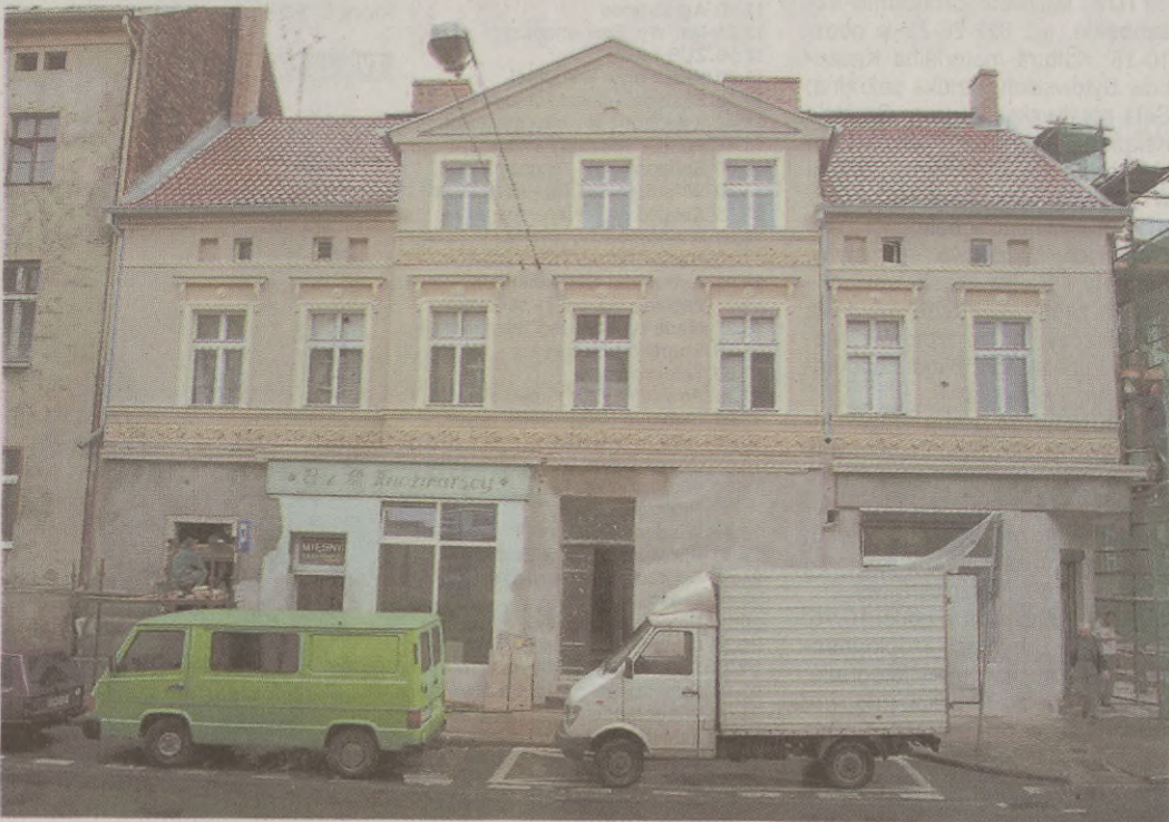
Ozdobne detale odzyskała już elewacja kamienicy przy ul. Armii Krajowej 4.
