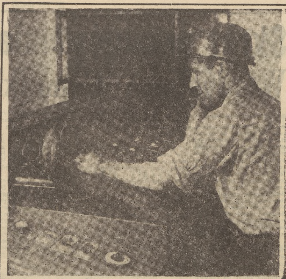
Automatyzacja szerokiego frontu wkracza do górnictwa. Oto automatyczne sterowanie pompowni w kopalni Bielszowice. Działanie pomp kontrolują urządzenia sygnalizacyjne na pulpicie sterowniczym.
