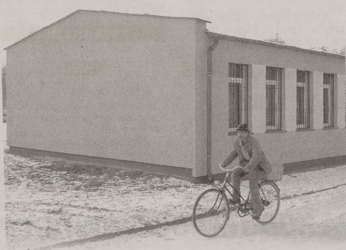
Wyremontowana świetlica w Kusowie, w gminie Słupsk.
