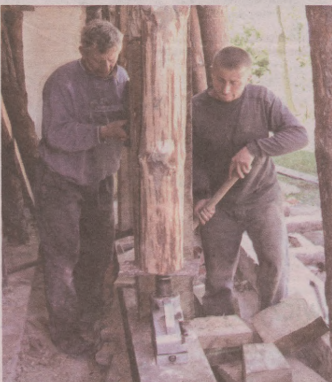
Pracownicy usuwają spróchniałe elementy belek podporowych zabytkowego XVII-wiecznego kościoła i zastępują je nowymi.
