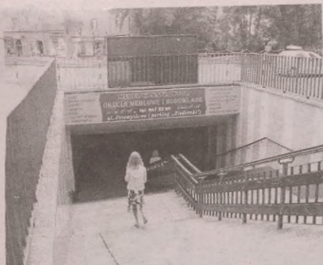
Przejście podziemne, ocena – 2,91.
