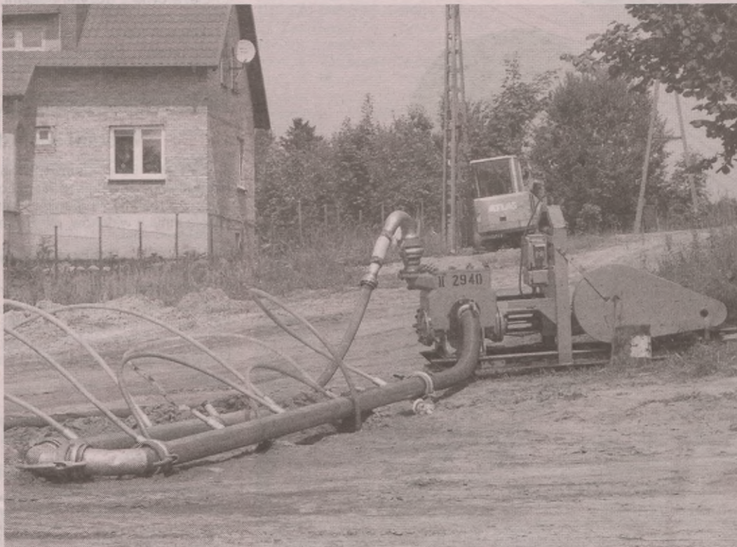
W piątek po południu prace w Charbrowie nie były prowadzone. Na budowie nie zastaliśmy ani jednego pracownika Wodremu.
