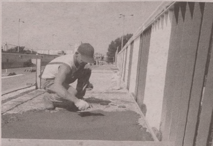
Nawierzchnia na wiadukcie na al. 3 Maja jest zmieniana na trwalszą.
