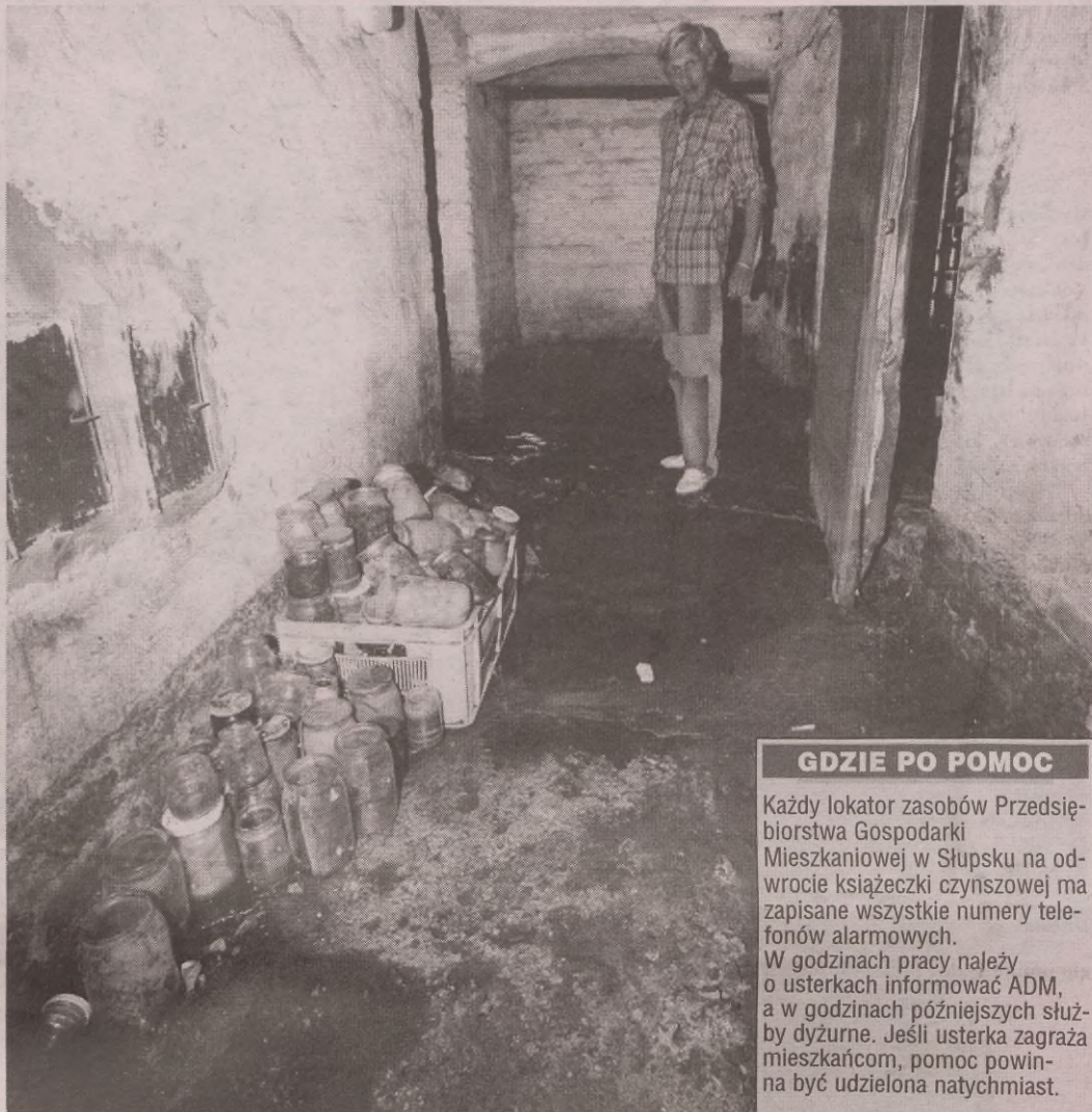
Pan Adam twierdzi, że woda w piwnicy stoi od kilku dni i chociaż z sąsiedzi zgłaszał awarię, nie przyszła żadna ekipa, żeby ją usnąć.
