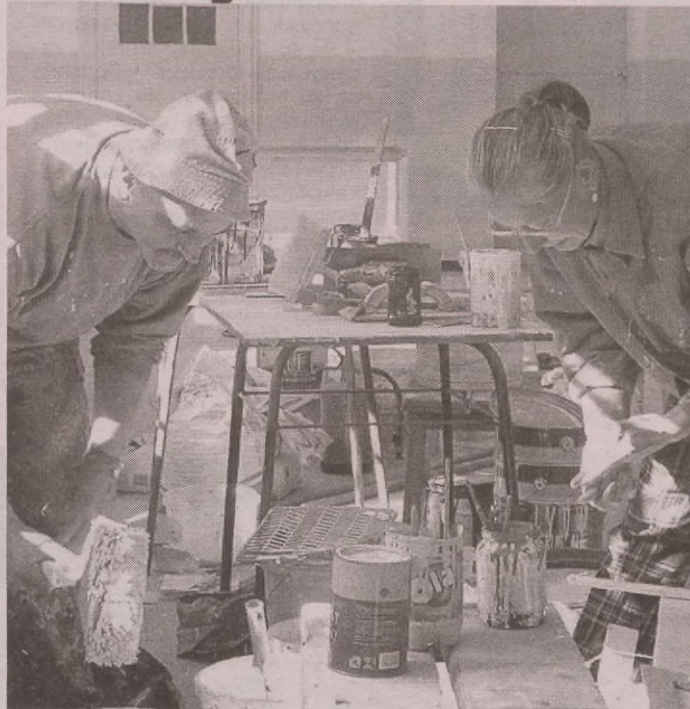
Ostatnie malarskie i porządkowe prace trwają w Szkole Podstawowej nr 1.
