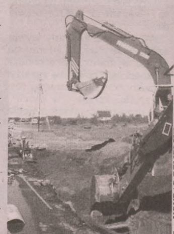
Wykop na budowie ronda wykonuje człuchowski Instal.
