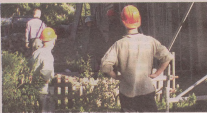
Mieszkańcy Niepogłędzia od razu po pożarze przystąpili do odbudowy.
